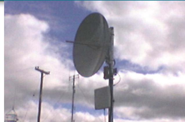
**Применение** : Линия подачи широкополосного сигнала операторского класса для Интернет-провайдера
